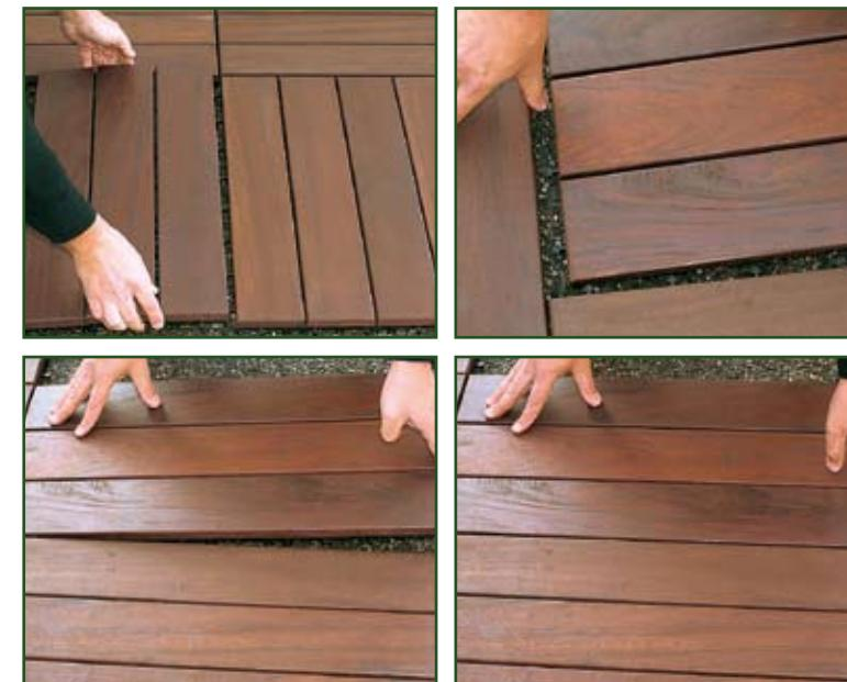
La posa è semplice e veloce, basta aver predisposto un adeguato sottofondo su una superficie regolare già pavimentata con ceramica o elementi lapidei o direttamente sul pavimento in cemento.
